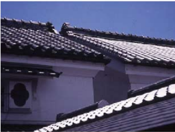
<「小島邸」蔵 手前は母屋から蔵へ続く廊下の屋根>
